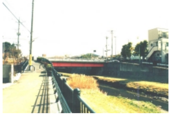
2000(平成12)年の御塔坂橋。上流左岸から撮影
