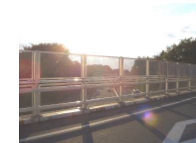
中央高速を渡る橋
