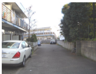
旧京王線跡に建てられたアパート 周辺の区画に対して斜めに建っている
